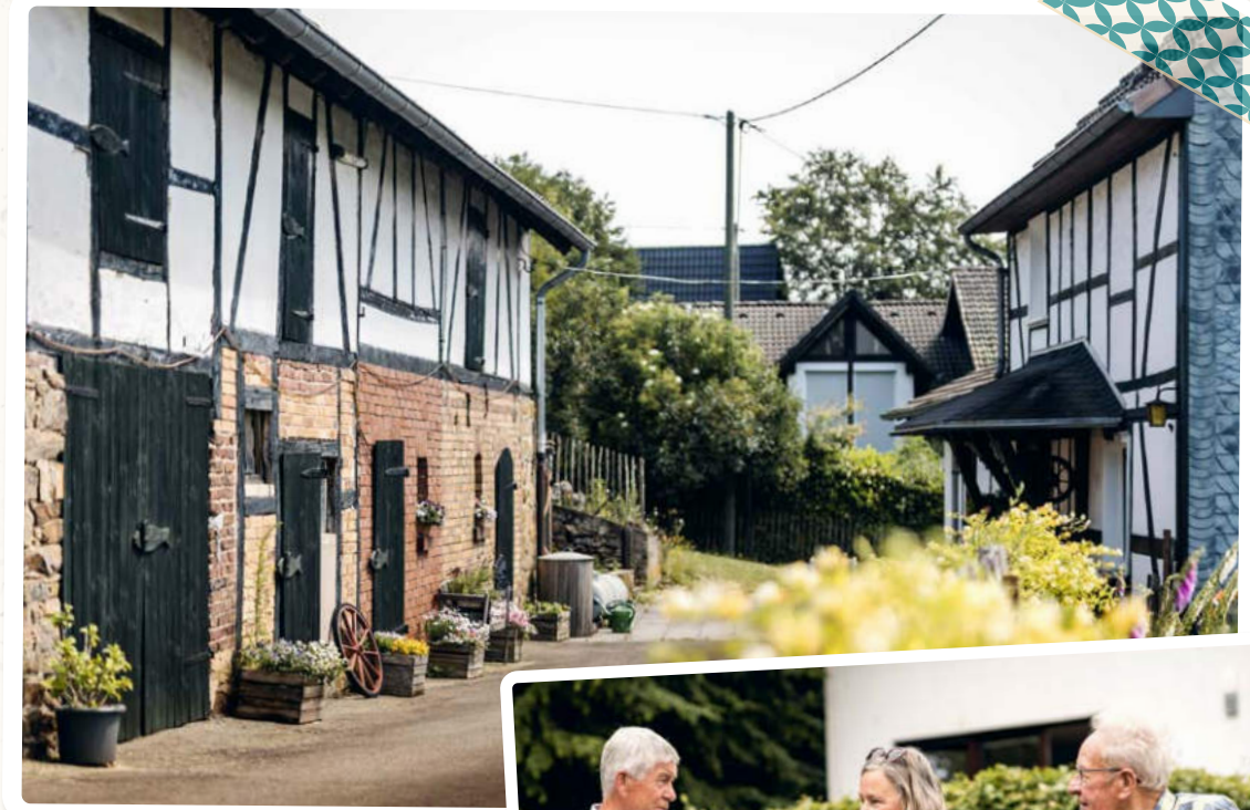
Benroth: moderne Energieversorgung in traditionellen Fachwerkhäusern.
